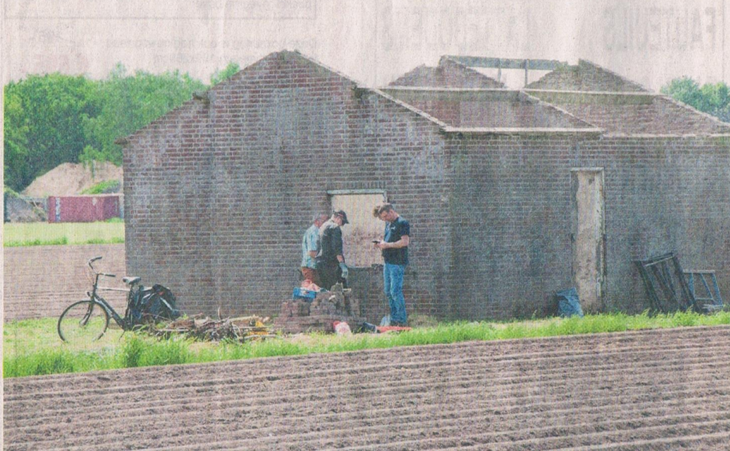
Het Wehrmachthuisje ligt aan de Kerkendijk. Vanaf de Smulderslaan is het gebouwtje goed te zien.
